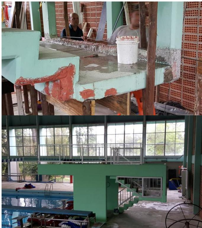
**Figura 14: Manutenção da estrutura do trampolim de salto**
