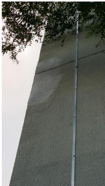
**Figura 4: Parte do sistema de proteção contra descargas atmosféricas.**
